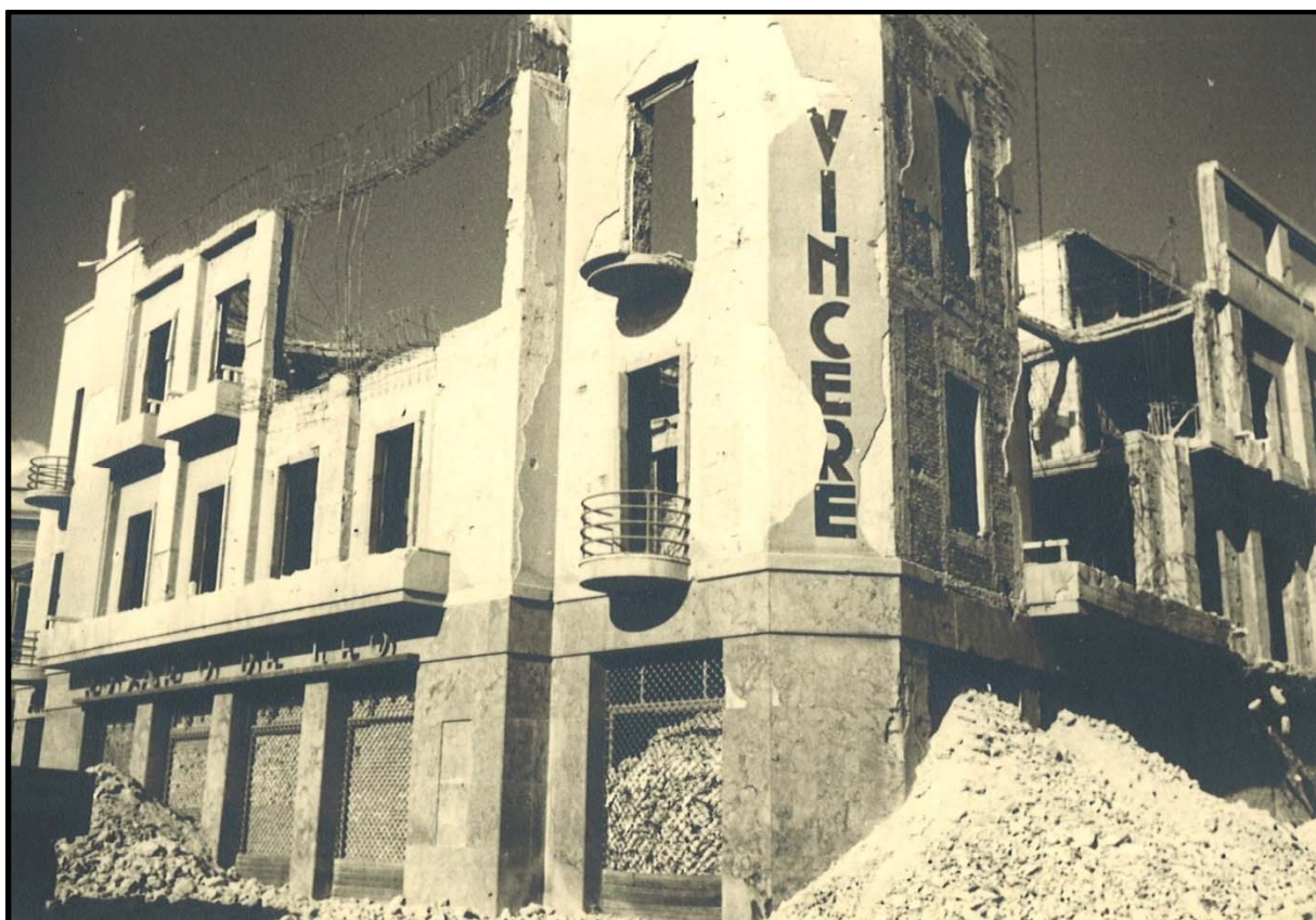
Figure 4 - Messina, Cortina del Porto, Via I Settembre (1945)
